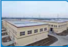
位於上海金山的塗料廠房 The coatings plant in Jinshan, Shanghai
