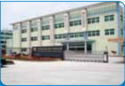
位於浙江桐鄉的油墨廠房 The inks plant in Tunxiang, Zhejiang
