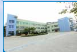
位於廣東中山的油墨廠房 The inks plant in Zhongshan, Guangdong
